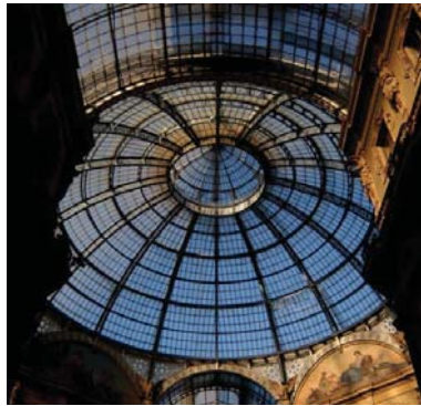
Abb. 3: Optimierte Statik: a) Galleria Vittorio Emmanuele, von radiären und konzentrischen Eisenträgern gestützte Glaskuppel über dem zentralen Platz (Foto: Shannon Kyles). b) Rasterelektronenmikroskopische Aufnahme von Arachnoidiscus mit radiären und konzentrischen Silikat (Glas-) Trägern, die eine ebenfalls aus Silikat bestehende Schale versteifen. Durchmesser ca. 50 µm (Bild aus ADIAC project, CEC contract. MAS3-CT97-0122).
